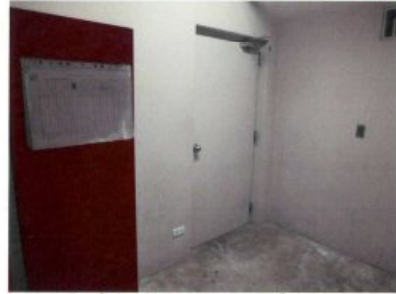
ลิฟต์ดับเพลิงสามารถขอใช้ได้ทุกชั้น มีพื้นที่ไม่น้อยกว่า 6 ตารางเมตร เป็นพื้นที่ปลอดควันและเปลวไฟ ไม่มีสิ่งกีดขวาง และเป็นที่ตั้งของตู้ดับเพลิงประจำชั้นของอาคาร
