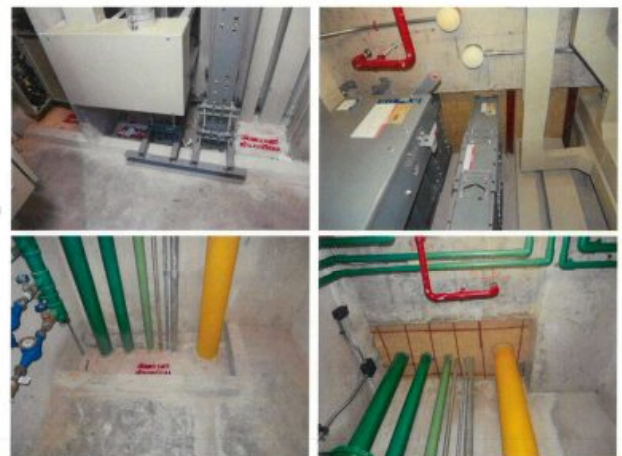
การปิดช่องเปิดระหว่างชั้น(ขารับงานระบบ)ป้องกันการแพร่กระจายควันไฟ
