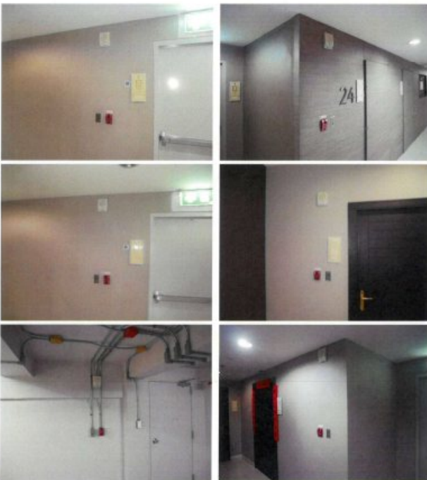
ภาพประกอบข้อมูลงานวิจัยพลเหตุถึง ไทมีหัวมือ และกระดิ่งเจ้าเหตุ มีการตรวจสอบเบื้องต้นจากทางฝ่ายอาคาร
