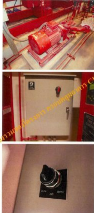
Jockey pump High Zone (ระบบปิดอยู่ เนื่องจากตู้ควบคุมยังไม่เปิดไฟดับเพลิง)
