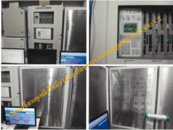
ภาพระบบสัญญาณแจ้งเหตุเพลิงไหม้ ตู้ FCP และ Graphic Annunciator มีการตรวจสอบเบื้องต้นจากทางฝ่ายอาคาร
