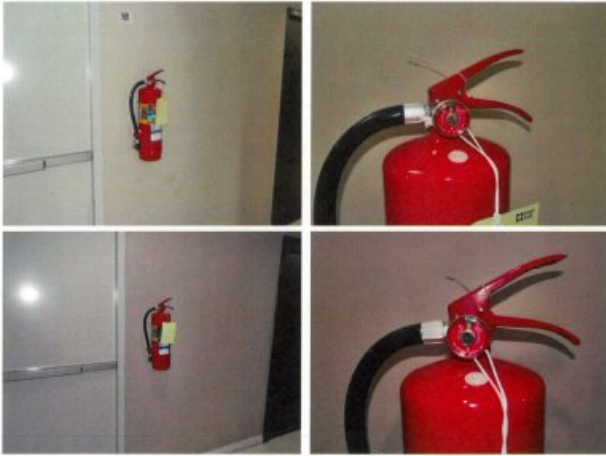
ภาพอุปกรณ์ดับเพลิง ดังดับเพลิง มีการตรวจสอบเบื้องต้นจากทางฝ่ายอาคาร
