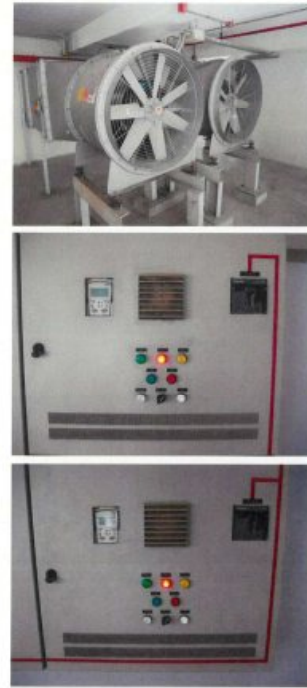
ภาพระบบพัดลมอัดอากาศและอุปกรณ์ประกอบ มีการตรวจสอบและดูแลจากช่างอาคาร
