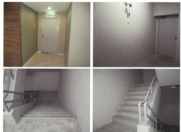
บันไดหนีไฟและเส้นทางหนีไฟ มีระบบแสงสว่าง ไม่มีสิ่งกีดขวาง ผนังหรือประตูที่ขัดขวางวิสัยทัศน์ สามารถใช้หนีไฟในกรณีฉุกเฉินได้
