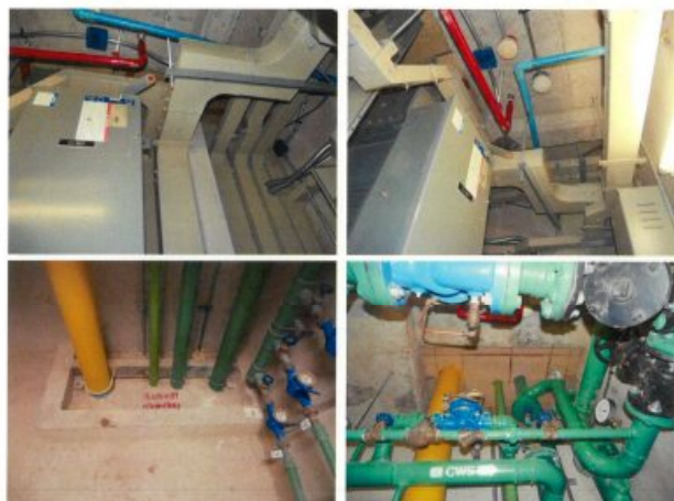
การปิดช่องเปิดระหว่างชั้น(ขารุปงานระบบ)ป้องกันการแพร่กระจายควันไฟ
