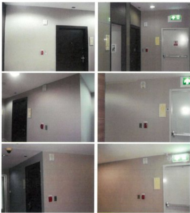
ภาพระบบสัญญาณแจ้งเหตุเพลิงไหม้ด้วยมือ และกระดิ่งแจ้งเหตุ มีการตรวจสอบเบื้องต้นจากทางฝ่ายอาคาร
