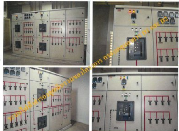
ภาพระบบไฟฟ้าสำรองจ่ายพลังงานไฟฟ้าให้ระบบสำคัญของอาคาร ลิฟต์บันทึกลง เครื่องสูบน้ำดับเพลิง และพัฒนาระบบความปลอดภัยของอาคาร
