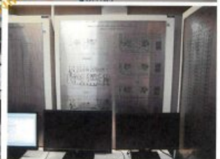
ภาพระบบสัญญาณแจ้งเหตุเพลิงไหม้ ตู้ FCP และ Graphic Annunciator มีการตรวจสอบป้องกันจากทางฝ่ายอาคาร
