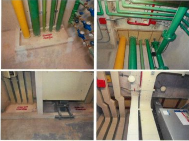
การปิดช่องเปิดระหว่างชั้น(ชั่วคราว)จนระบบป้องกันการแพร่กระจายควันไฟ
